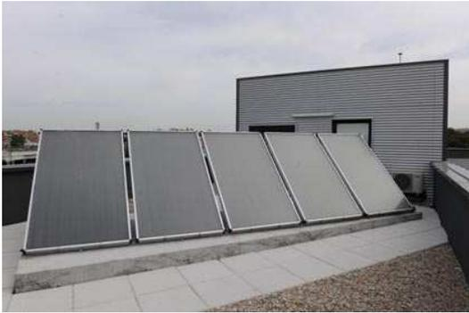
Se contempla la colocación de paneles solares térmicos para la producción del 60% del agua caliente sanitaria del edificio. Consta de 16 paneles solares con una superficie de 2,1 m<sup>2</sup>. Al disponer el edificio de calderas individuales de gas natural, se ha optado por la colocación de depósitos individuales de acumulación por vivienda de 80 l. El
